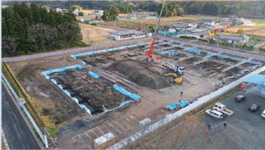
太陽の国敷地内に建設が進められています。令和6年9月末の完成を予定しております。
