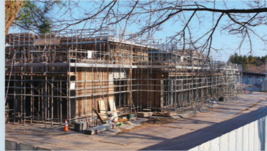
けやき荘の隣接地に、建設が進められています。令和5年度末の完成、6年度中の引越を予定しています。
