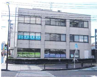
移転先：白河市道場小路91-5 第6大成プラザ1階
