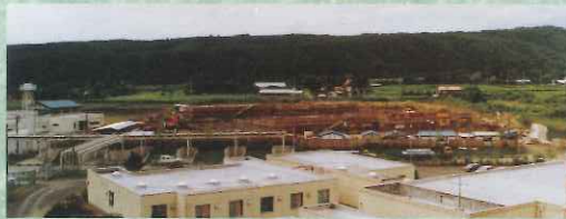
かえで荘建設中(昭和54年)
